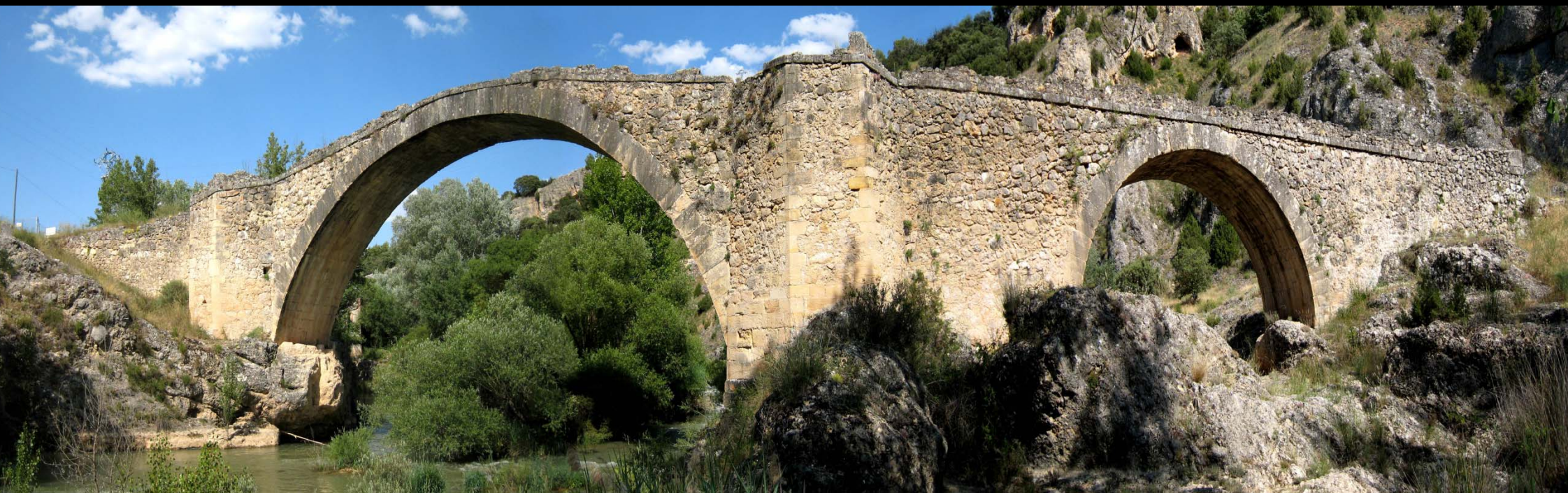
Puente del Castellar sobre el Río Júcar, en Fresneda de Altarejos. SE Hoja de San Lorenzo de la Parrilla. (por Olcade-Google)
